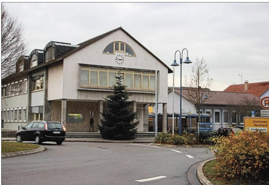
ÜBER DIE SANIERUNG beider Rathäuser muss sich der Gemeinderat im nächsten Jahr Gedanken machen. Im Ortsteil Karlsdorf ist ein Anbau in Kooperation mit der Sparkasse derzeit vom Tisch. Foto: Herberger
