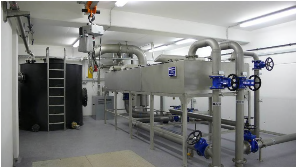
Abbildung 8 Beispiel eines Flachbettbelüfters mit Zuluftgebläse im Hintergrund
