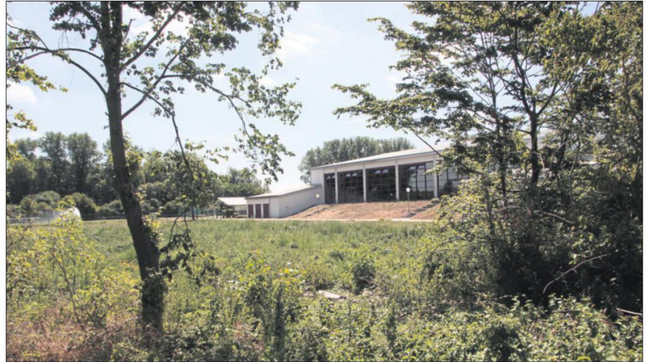
PLATZ FÜR SPORTLER: Für den Bau der zweiten Halle beim Altenbürgzentrum in Karlsdorf-Neuthard wurden bereits Bäume gefällt. Sorgen bereitet Mitgliedern des Gemeinderats allerdings die Kostensteigerung des geplanten Bauwerks. Foto: Herberger
