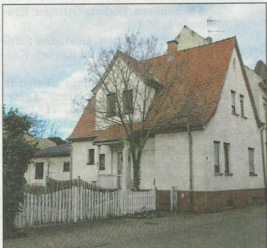
IN DIESEM HAUS in der Amalienstraße soll eine erste Anschlussunterbringung für Asylbewerber entstehen. Foto: ber
