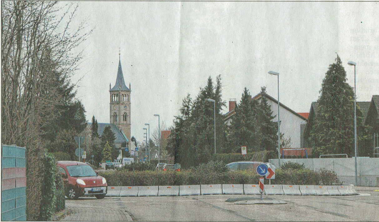
NUR OPTISCHE AUFWERTUNG? Der provisorische Kreisel in der Büchenauer Straße wird für insgesamt 400 000 Euro ausgebaut. Die Freien Wähler und die Grünen bemängeln die hohen Kosten.
